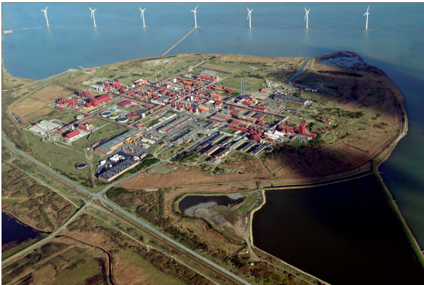
Luffoto af Cheminovas produktionsanlæg på Rønland. Det biologiske rensningsanlæg ligger i det sydvestlige hjørne af fabriksarealet og ses nederst til venstre.
