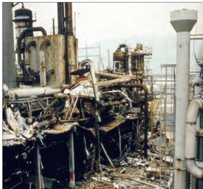
Figur 1. Skader efter detonation af 3½-7 kg brint i en bygning (Kilde: Bjerketvedt and Mjaavatten, 2005).
