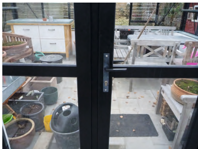
Figur 2. Håndtag, på et malet drivhus af aluminium, som har været udsat for sollys og fugt igennem en enkelt dansk sommer. Det er tydeligt, at produktet ikke er passende stabiliseret mod nedbrydning og hurtigt opnår et kedeligt mathvidt udseende. På indersiden af døren har håndtaget bevaret sin oprindelige pæne sorte farve. Foto fra forfatterens have.
