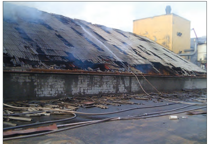
De begrænsede skader på tagplader viser, at eksplosionstrykket har været beskedent. Der er ingen tryk-skader på ydervægge. (Kilde: Beredskab Vesthimmerland).
