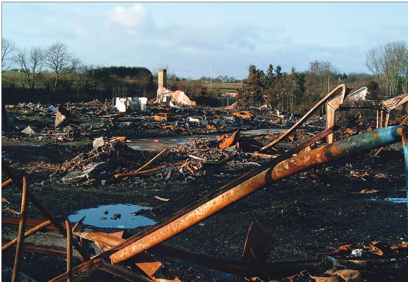
Efter ulykken i Seest flød brandtomten med ueksploderet fyrværkeri, forvredne gitterkonstruktioner og ståldragere fra lagerhallerne og enkelte udbrændte bilvrag. Foto: Frank Hedlund, 2005.
