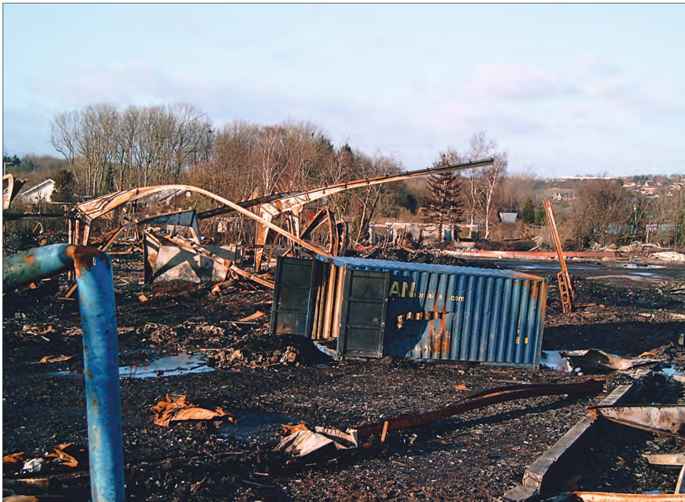
Efter ulykken i Seest: Udbrændt container og forvredne stålspær. Bemærk den korte afstand til de nærmeste beboelseshuse til venstre i billedet. Nederst til højre ses formentlig resterne af et fundament til en lagerhal. Foto: Frank Hedlund, 2005.
