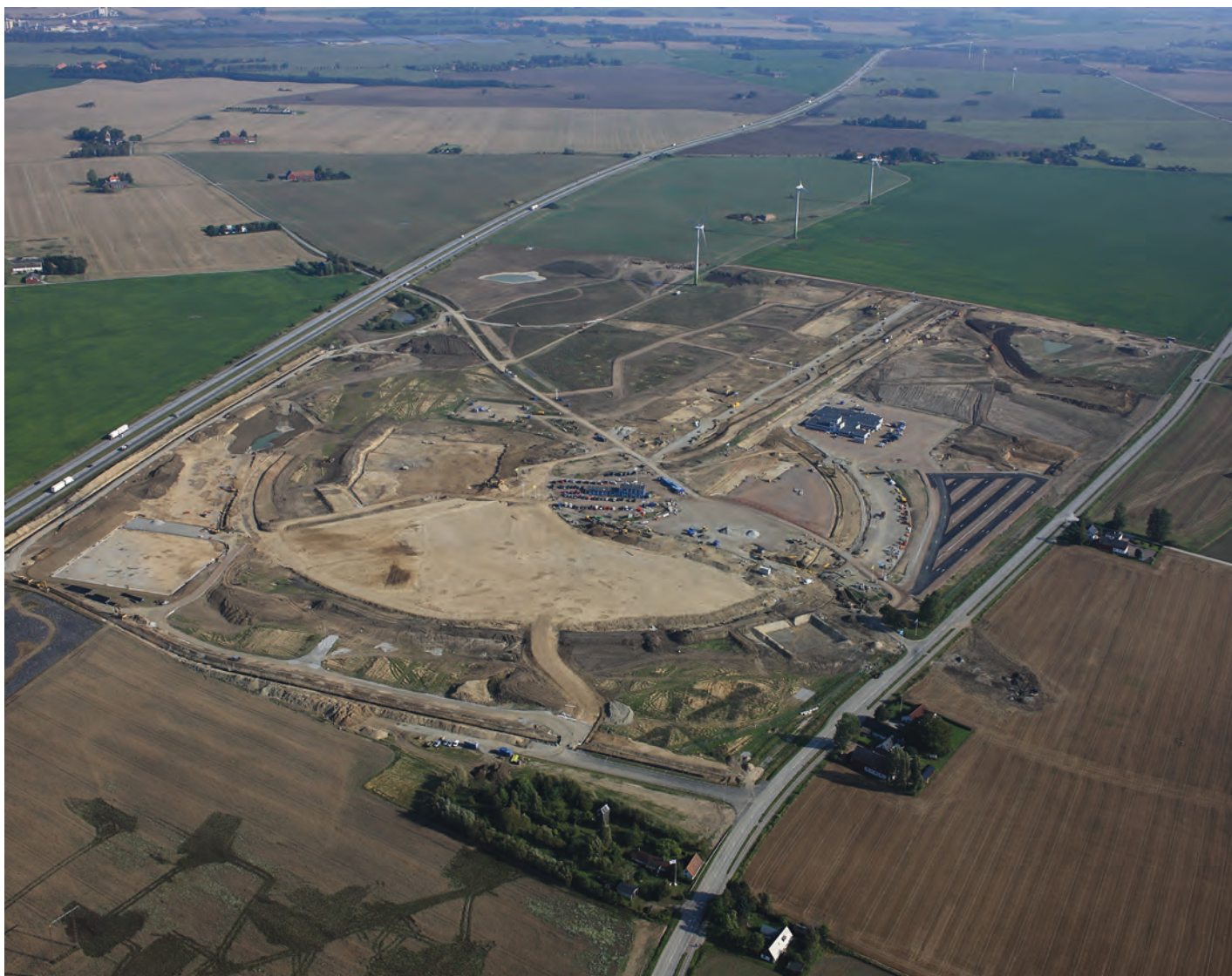
Her skal ESS bygges.
