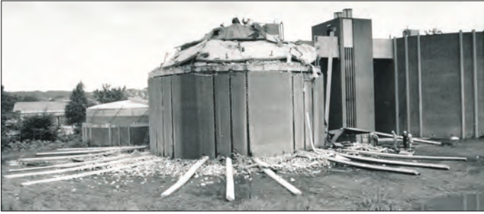
Pyntesøjler af beton var væltet bort fra tanken. En af betonsøjlerne hang meget usikkert mod trappetårnet. Bemærk rester af udluftningsslangen, der hænger ned fra taget, samt den intakte(?) identiske rådnetank til højre. Foto: Vejle Amts Folkeblad.
