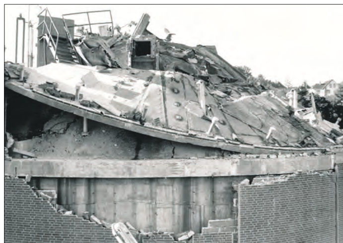
Det kollapsede betondæk lagde sig på rådnetankens topkegle. Under ringbjælken ses revne i tankvæggen. Foto: Vejle Amts Folkeblad.
