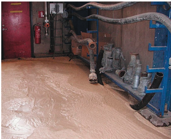
Figur 2. Illustration af gipsafsætninger i området omkring et afsvovlingsanlæg efter overløb af opbevaringstanke.
