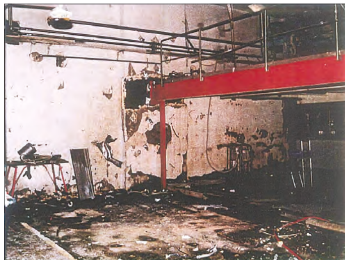
Ulykkestanken detonerede med så stor kraft, at fragmenter borede sig ind i kælderen's meget solide betolvægge.
