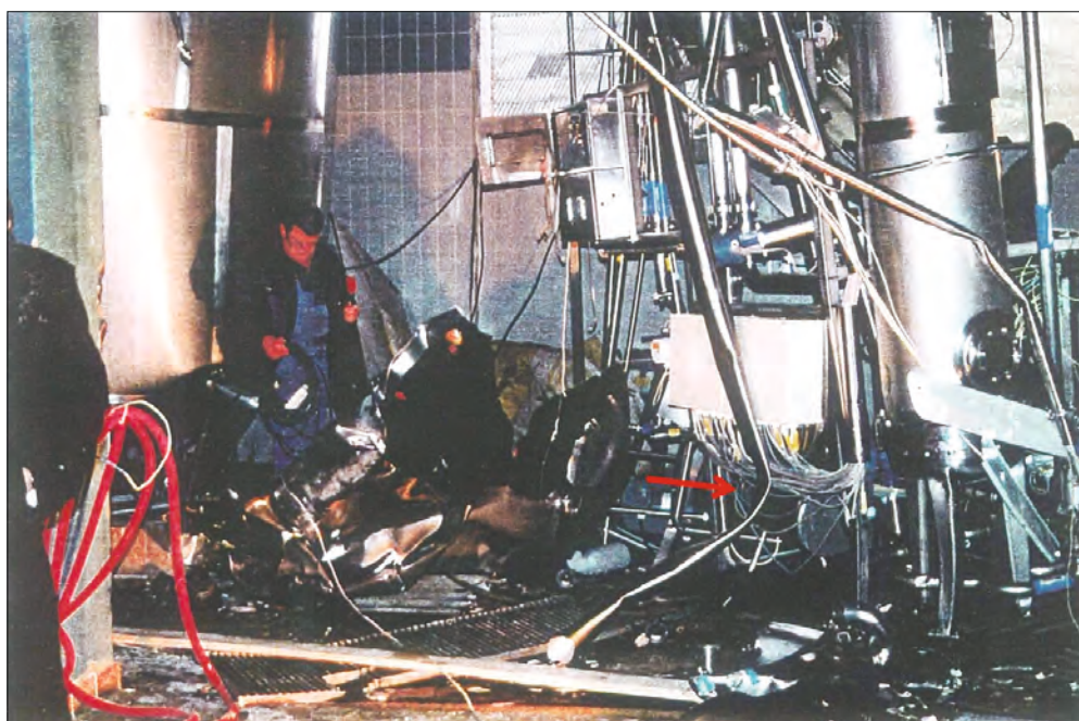
Ødelæggelserne i brygkælderen var omfattende, bemærk at rør af rustfrit stål (pil) er fladtrykt.
