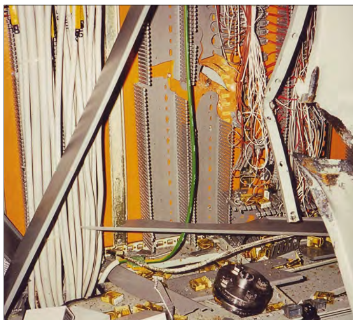
8-10 kg flange af rustfrit stål blev slynget gennem kælderrummet, hvor den ramte et el-skab, medførte kortslutning og strømsvigt.
