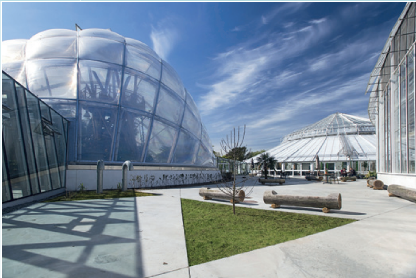
Det 18 meter høje væksthuse i forgrunden er tilføjet de øvrige fem væksthuse. Alt i alt er der 3.300 kvadratmeter under tag.
