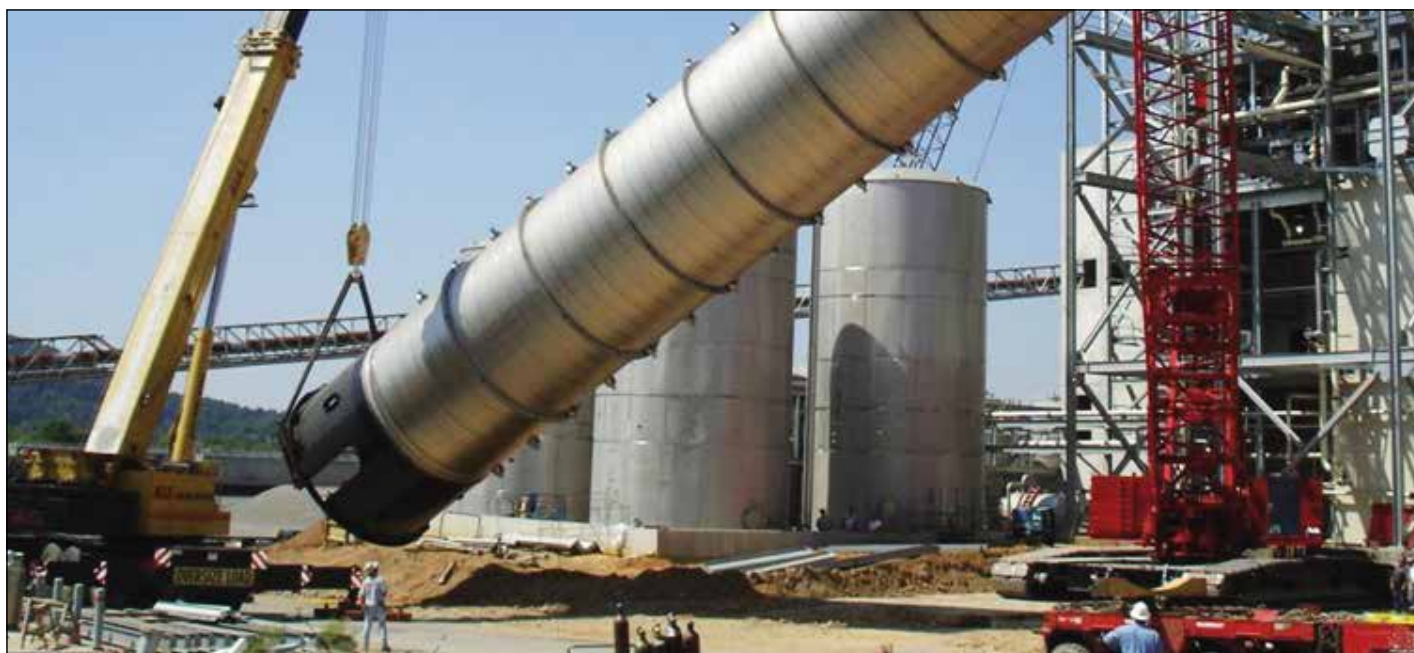
400 m 3 bobble-kolonne reaktor opført i 2003 af DuPont til fremstilling af 25.000 ton/år 1,3 propandiol. Reaktoren er en ud af 10 ens i anlægget.
