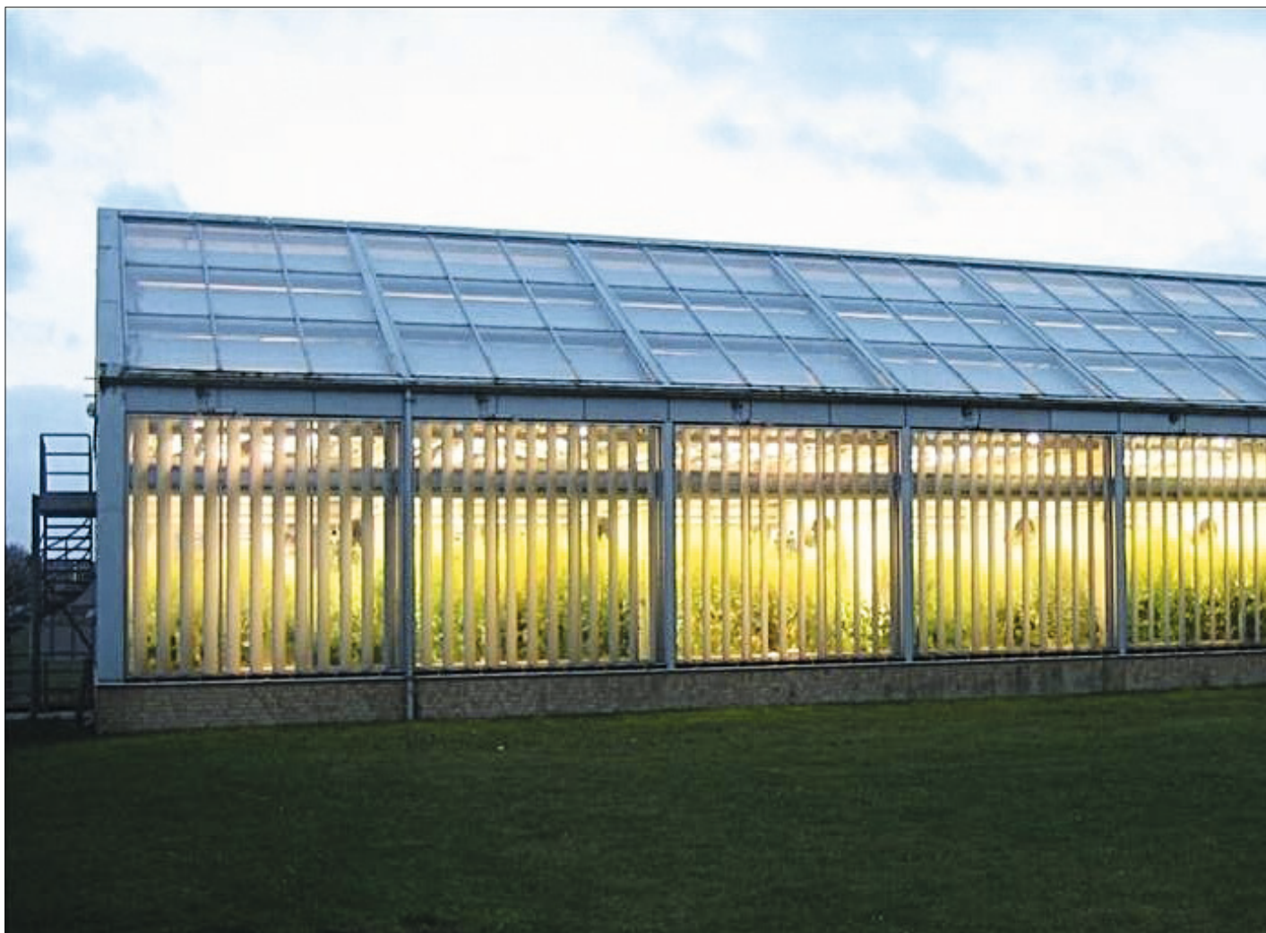
Klima-phytotronen. I kamrene på hver 24 m 2 kan temperatur, atmosfære-sammensætning, fugtighed, vind, vanding mv. kontrolleres. Lyssætningen kan for eksempel simulere dagsfaserne, solopgang, fuld lys, solnedgang. Kamrene reguleres enkeltvis, og alle parametre monitoreres løbende.
