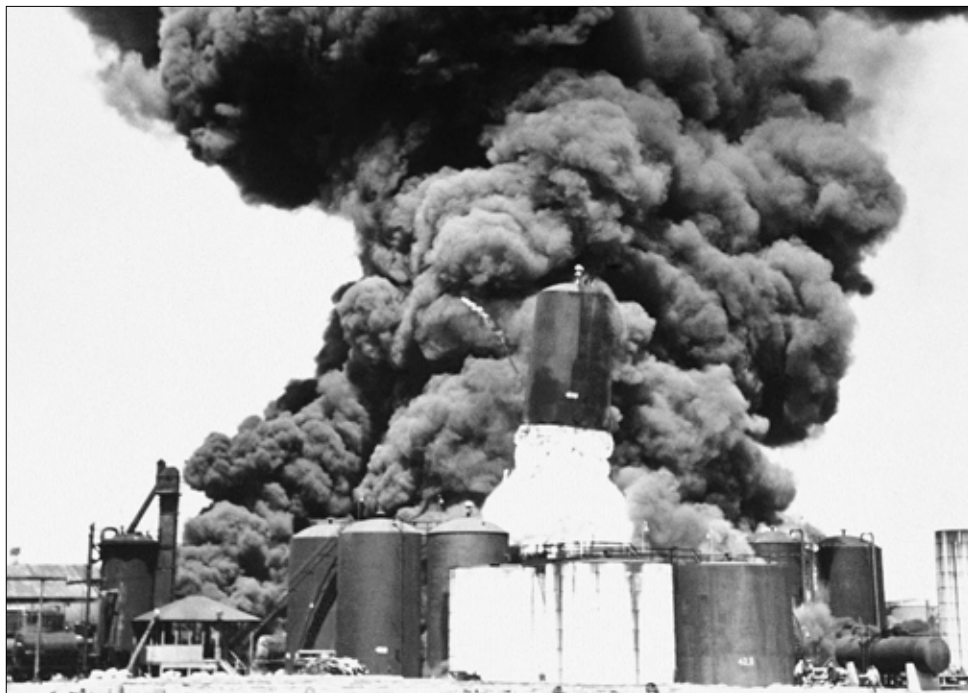
Figur 2. Det er klart at foretrække, at samlingen i taget er det svageste led, hvis der opstår indre overtryk i tanken. Den svageste svejssesøm i denne tank var desværre i bunden. Et overtryk fik tanken til at skyde 15 m i vejret og tømme sit indhold af 160 tons brændende asfalt ud af åbningen i bunden. Bemærk, at der også strømmer brændende asfalt ud af et overrevet rør til venstre for tanken. Denne svigttype er sket flere gange, men forfatterne kender kun til eksistensen af dette ene foto fra 1949, hvor en fotograf var hurtig på udløseren. Bemærk de flygtende mennesker nederst til højre i billedet. Foto: APlimages/Polfoto.
