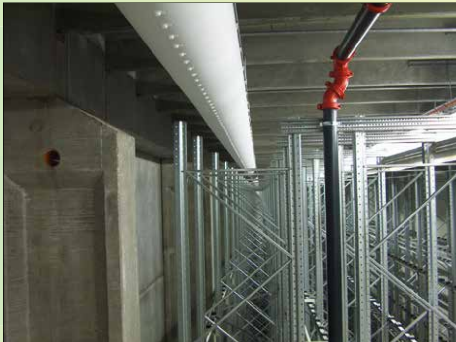
Ostemodningslager: Krav om ens rumfugtighed, luftfugtighed og temperaturvarians på \pm 1^\circ\text{C} løses bedst med tekstilkkanaler pga. den jævne luftfordeling og høje præcision, indblæsnings-teknologien tilbyder.
