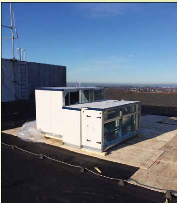
I forbindelse med projektet blev der opført en midlertidig udvendig elevator til at transportere de store aggregater til 14. etage.
