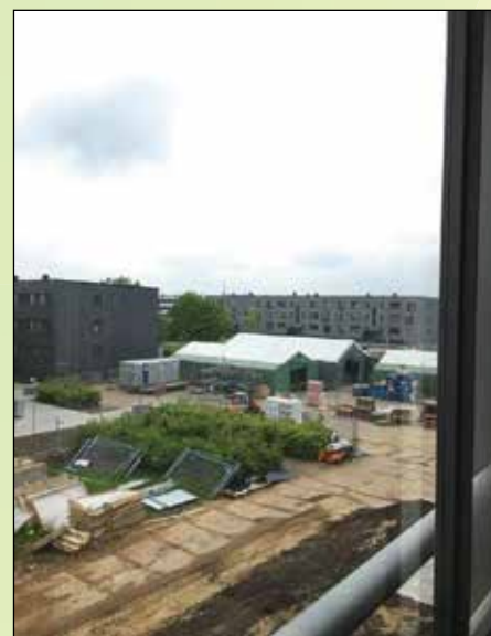
Langkærparken er ikke længere nogen byggeplads, men det var omfattende, mens renoveringen stod på.
