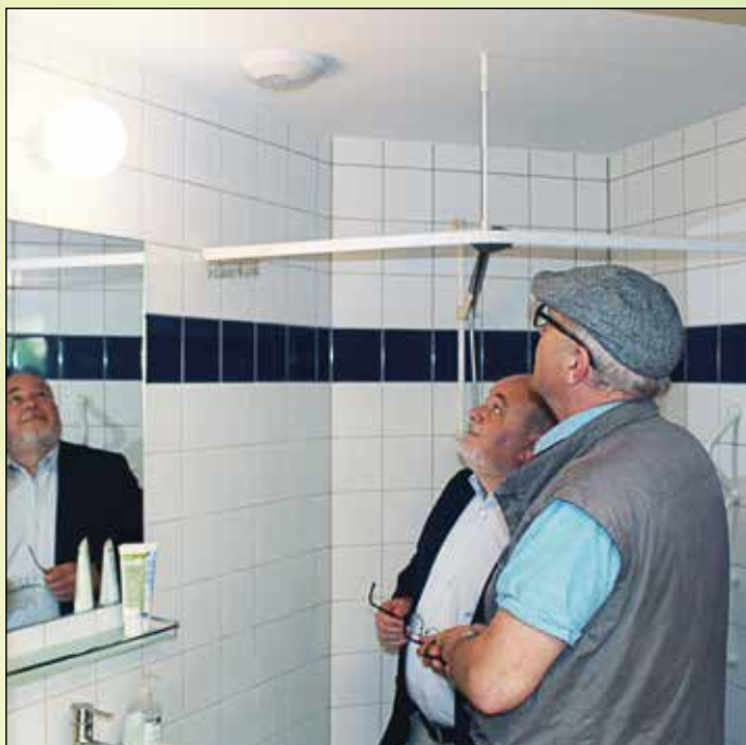
Neotherm-ventilen på badeværelset åbner og lukker for ventilationen efter behov.
