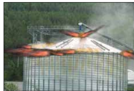
En kunstners afbildning af stikflammer fra eksplosionen i træpillesiloen, som skyldtes, at pyrolysegasser formentlig blev antændt af statisk elektricitet dannet ved tømningen af en kulsyreflaske.
