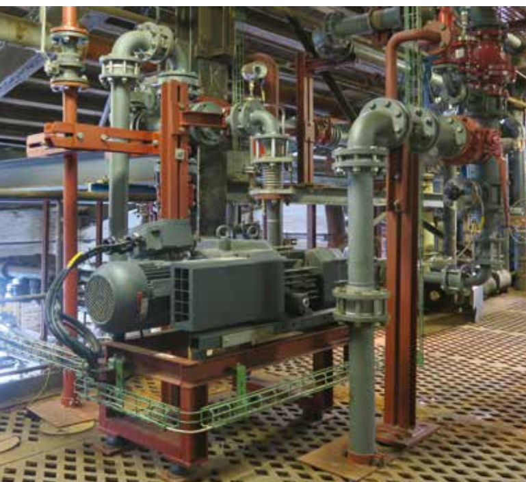
Figur 1. Mink klovakuumpumpe til transport af udstødningsgasser, der indeholder chlorerede kulbrinter hos Nouryon.
