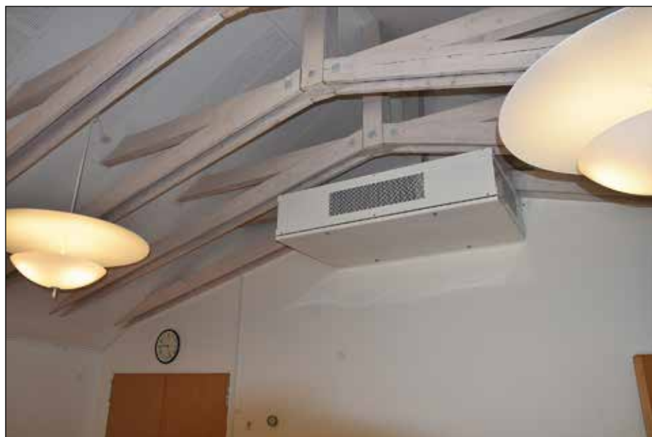
I aktivitetscenteret Knudepunktet i Vejen er monteret en Duka One Q500L (loftenhed) i centerets fælleslokale.
