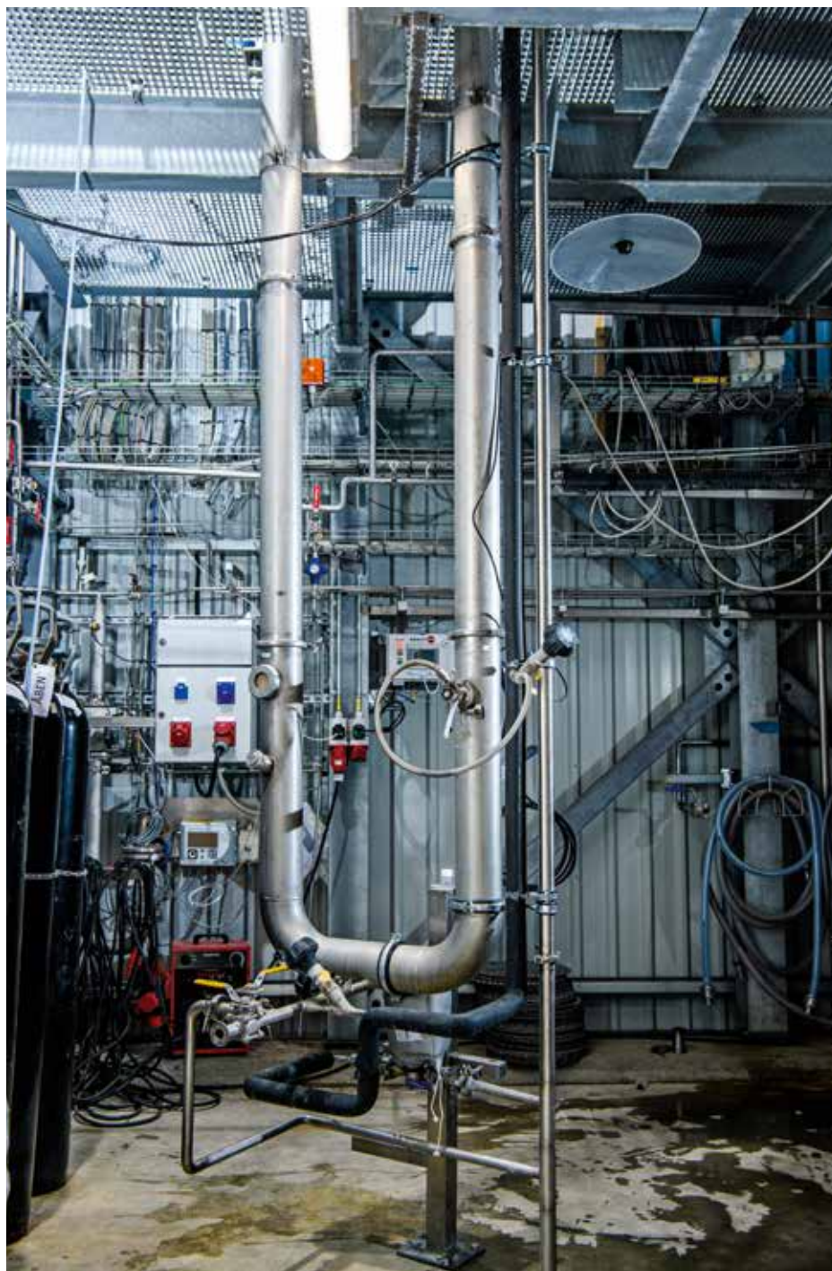
Pilot U-Loop installeret på Unibios faciliteter i Kalundborg.
