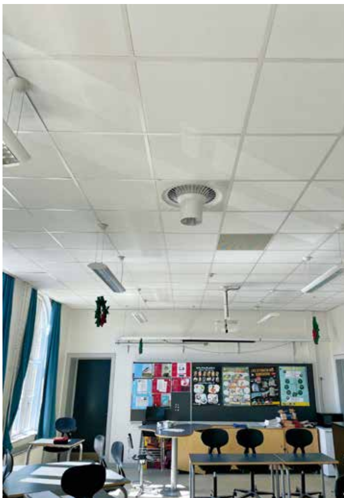
Her er en Airius-blæser installeret i et undervisningslokale, hvor den ioniserede luft forbedrer indeklimaet.
