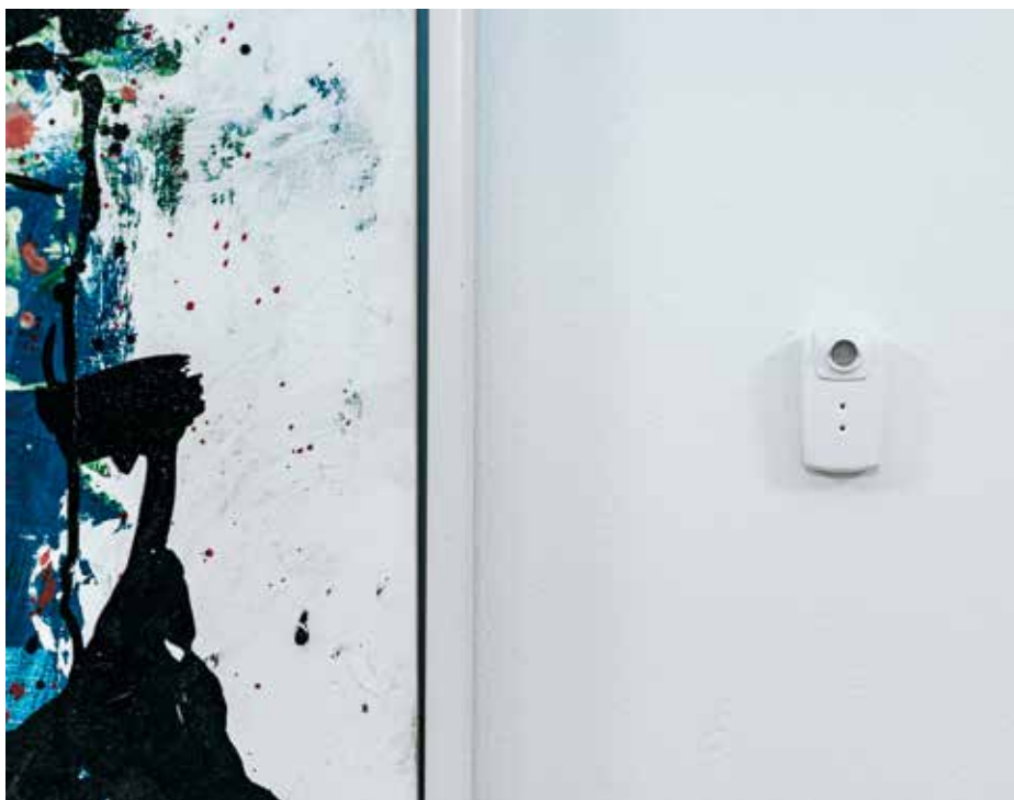
Bluetooth-sensoren forbindes med VAV-spjældet ved hjælp af OneLink appen og giver mulighed for at opdele ventilationen i forskellige zoner.
