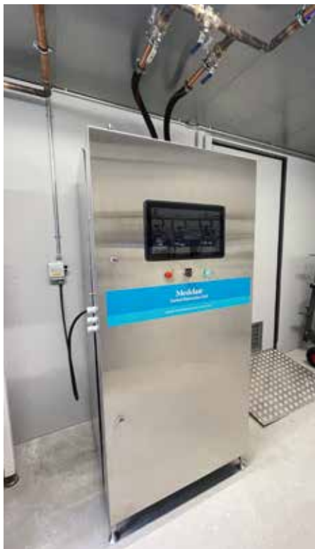
Dimensionerne på N 2 O nedbrydningsanlægget er 90 x 80 x 190 cm. Vægt 300 kilo.
