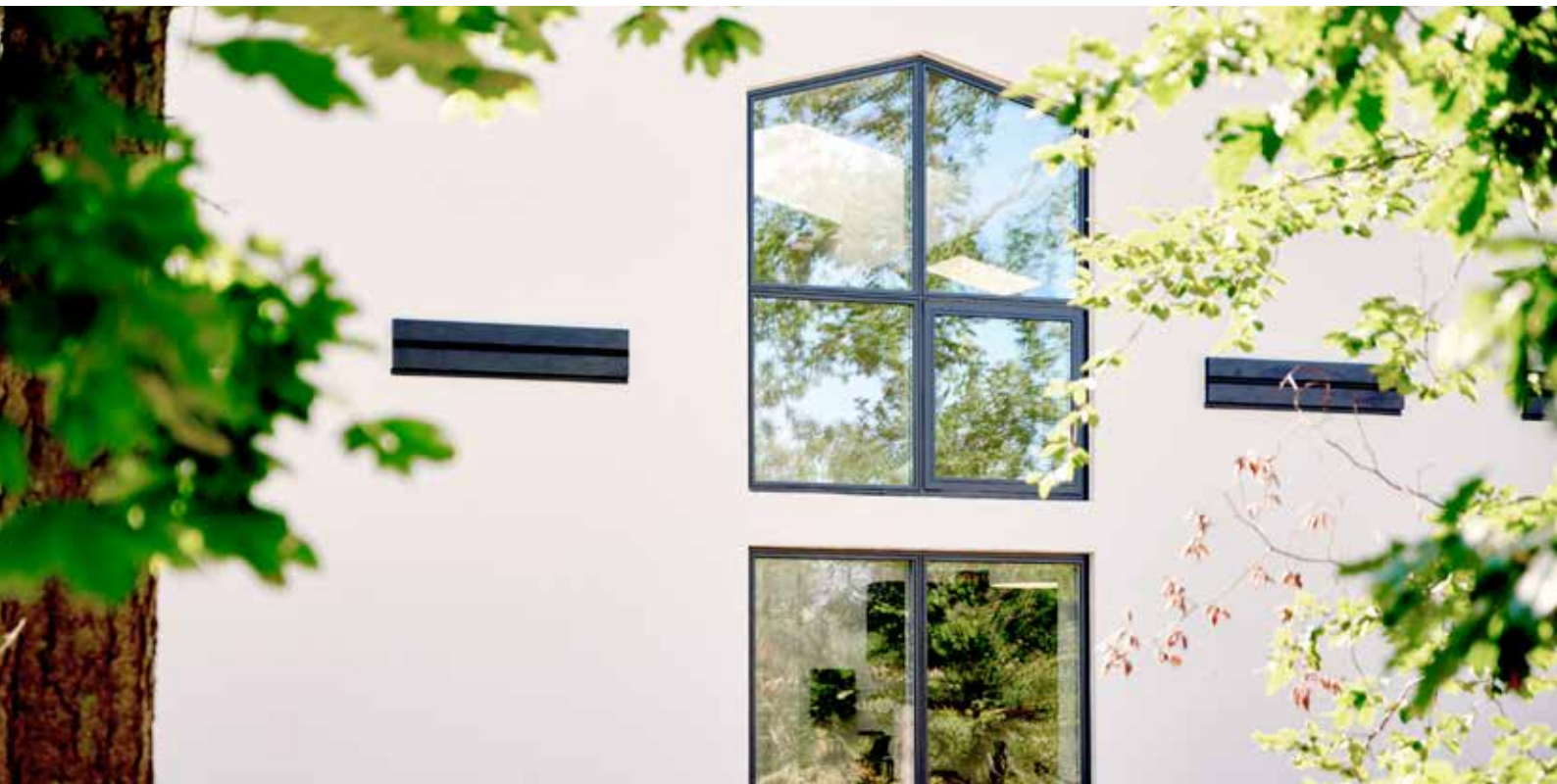
Lægehuset Vejlsø, Silkeborg. MicroVent monteret vandret i facade ved siden af vindue.
