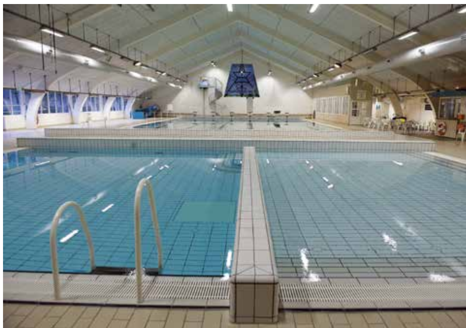
Løkken Svømmehal, hvor Venti har leveret en energibesparende Euroclima-løsning.
