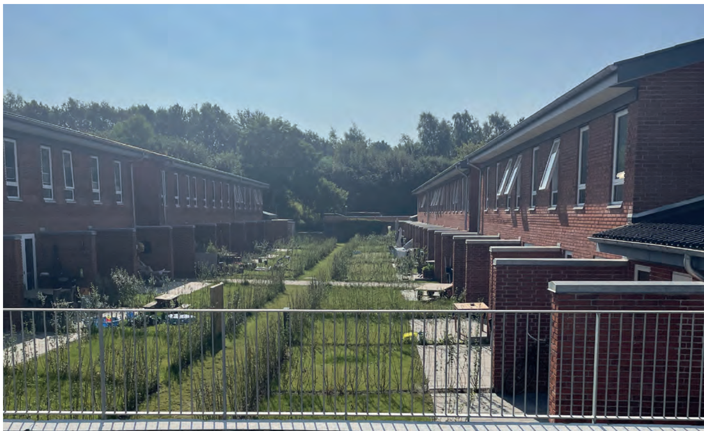
Skt. Klemensparken i udkanten af Odense gennemgår en gennemgribende renovering med fokus på både energirenovering og indeklima.
