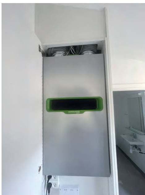
I boligerne i Skt. Klemensparken er aggregaterne installeret både på loftet og, som her vist, i et standardskab. Rørføringen er skjult i kasser.
