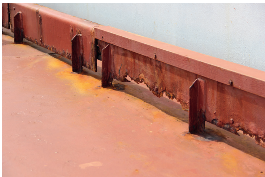
Figur 5. Når skarpe kanter ikke afrundes før påføring af maling, giver malingen ikke tilstrækkelig beskyttelse og korrosion tager godt fat netop her.
