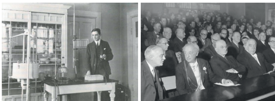
Figur 2. Til venstre: 31-årige Detlev Müller i sit KVL-laboratorium 1931 [7]. Til venstre pressen til udpresning af GOx-holdig saft fra svampeprøverne, i midten glasbeholderen med kviksølvmanometer til at følge O 2 -optagelse. Bagved morter og pistil til at støde svampeprøverne med sand og kiselgur inden udpresningen.
