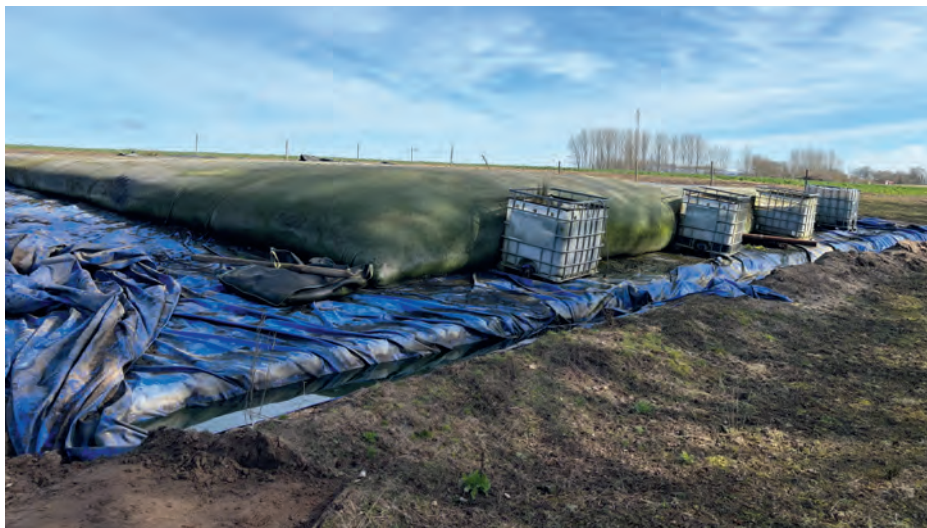
Geotekstilposer fyldt op med vådt sediment. De store poser ligger på presenninger, så vandet kan samles sammen, sendes over i et sandfilter og derefter tilbage til søen.
