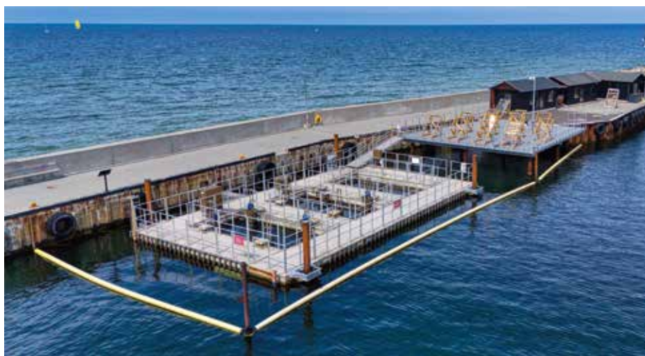
Figur 1. CoaST Maritime Test Centre (CMTC) på Hundested Havn. Forrest i billedet ses den flydende platform, som især anvendes til test af antibegroningsmaling, midt i billedet ses den nyetablerede platform med skrå stativer til test af rustbeskyttende malinger og bagest i billedet ses tre sorte småhuse fungerende som værksteder og kontor.
